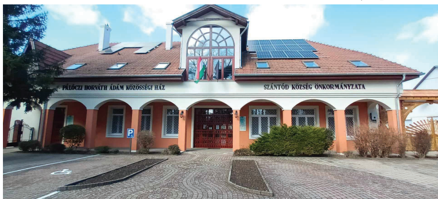
A felújított közösségi ház
