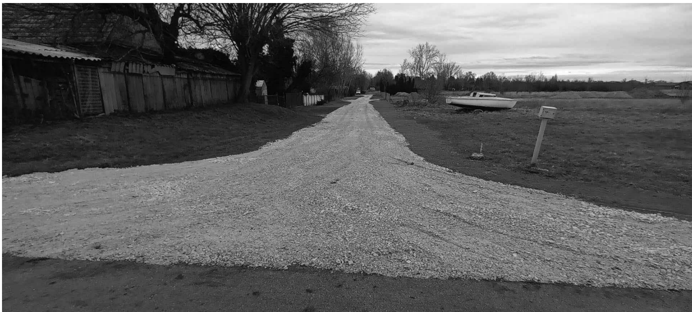
Fejlesztés Elkészült a Rét utca Hajnal utca felőli első szakaszának murvázása
